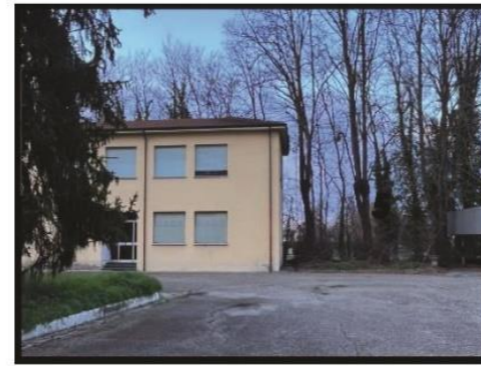
Fabbricato ex uffici; risiede il custode; pesa a ponte fissa
